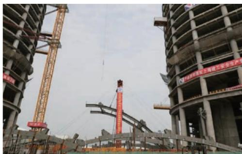
**本报讯** 4月22日,由杭萧钢构股份有限公司(以下简称“杭萧钢构”)承建的杭州之门钢结构工程随着TB-C轴、TB-E轴钢拱顺利提升至22米高空,标志着本项目钢拱连桥部位的旋转起扳提升工程正式启动。
