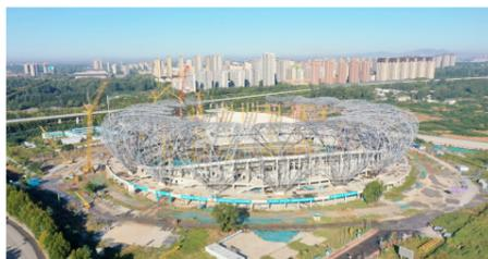
10月中旬，由杭萧钢构（河南）有限公司（以下简称“河南杭萧”）承建的许昌体育会展中心项目（一期）体育场钢结构工程，主桁架施工进入最后冲刺阶段，整体造型已初步显现，仿佛一朵莲花盛开在蓝天白云下。
