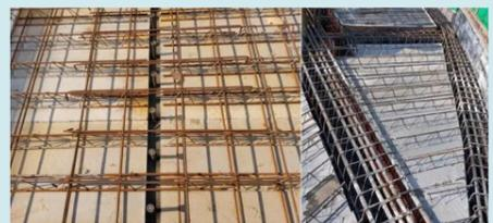
免拆底模钢筋桁架楼承板在工厂批量化生产，运输至现场即可铺装，施工速度快，现场不需要铺设模板工程，减少不规范设置支模体系带来的安全风险；作为工厂化生产的装配式绿色建材，较传统产品相比，能有效减少建筑垃圾产生。
