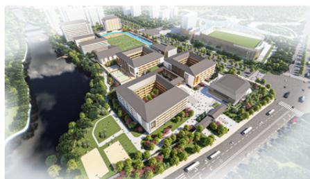
6#男生宿舍地上6层，建筑高度23.94m；7#女生宿舍地上12层，建筑高度45.15m；8#教师公寓地上10层，建筑高度34.14m。该项目主体规划为寄宿制完全中学，办学规模为48班，学生人数1860人。
