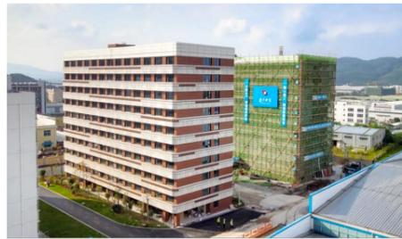
该项目位于广东省江门市开平市环翠南路，总建筑面积约为20000m<sup>2</sup>，主要建筑形式为钢框架结构，包含2栋10层综合大楼与1栋配套消防水泵房，设有396间隔离观察房间，为中高风险地区到来人员及本地次密接等人员集中隔离使用，疫情后将通过功能转换作为酒店使用，在助力开平常态化疫情防控工作的同时，进一步强化开平市基础设施建设支撑保障，
