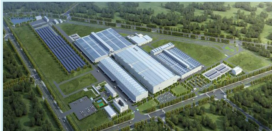
长三角一体化滁州市新能源汽车产业园项目一期工程
